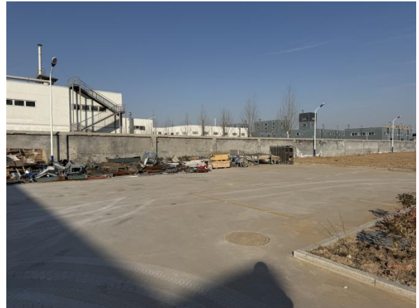
事故水池（地下）
