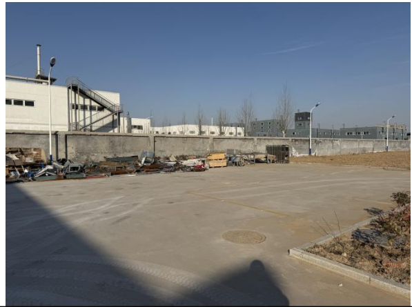
事故水池（地下）
